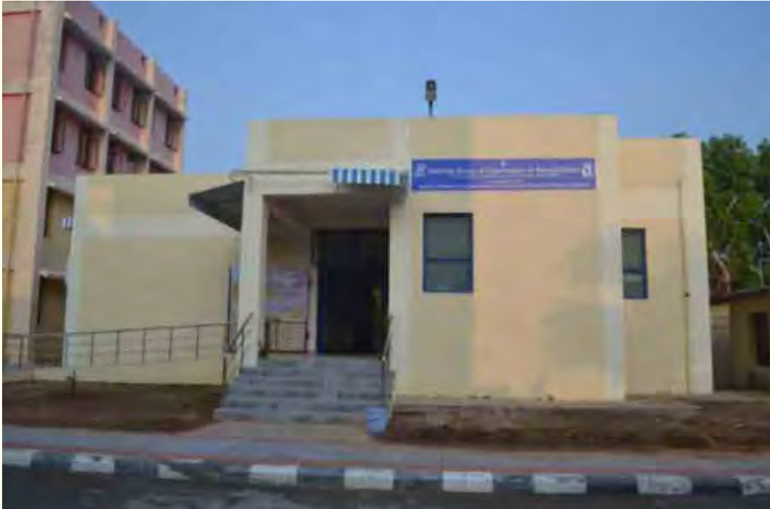
एन.आई.ई.पी.एम.डी. में एन.बी.ई.आर. भवन
